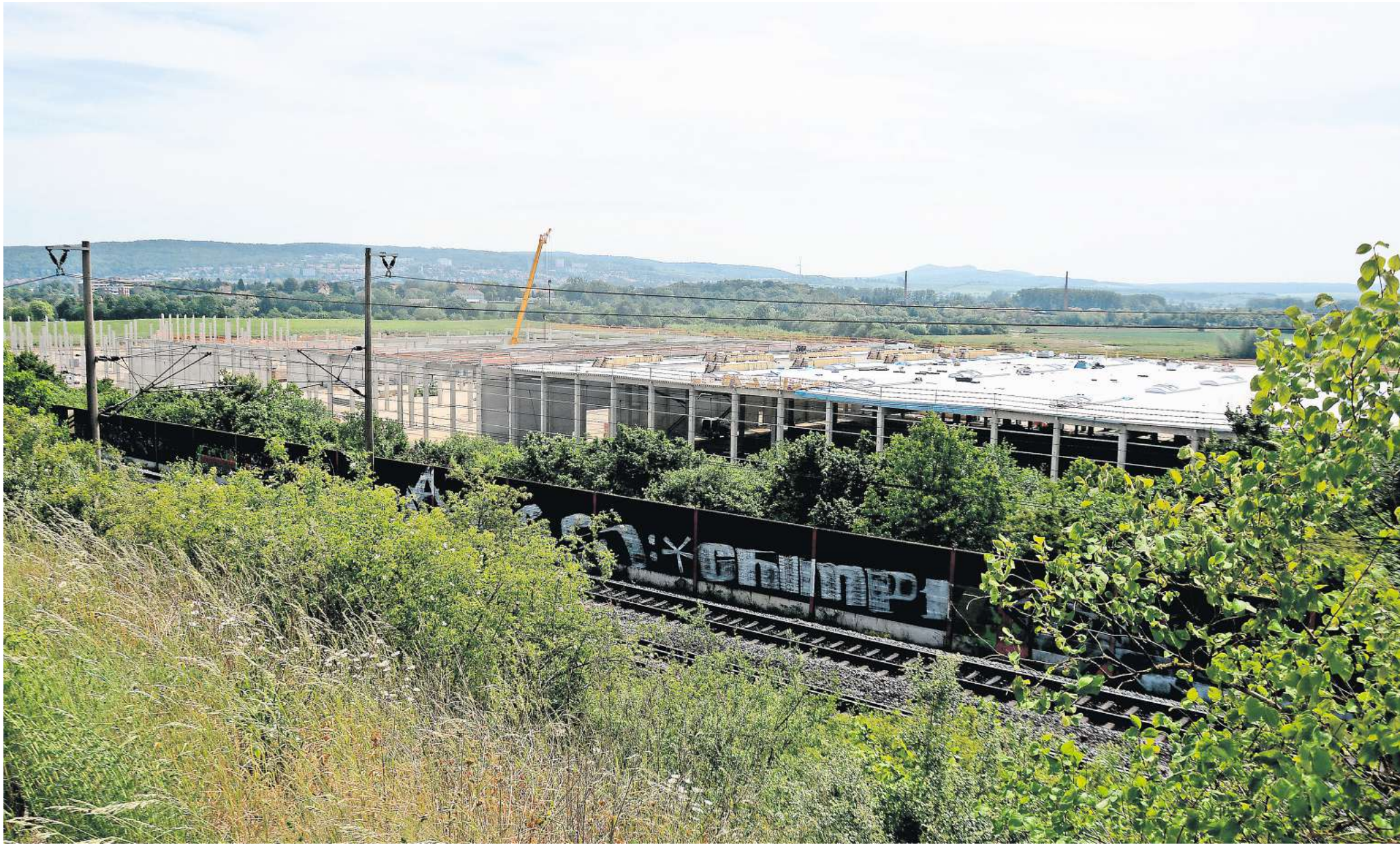
Am Siekanger errichtet die VGP Industriepark GmbH eine 40 000 Quadratmeter große Halle.
